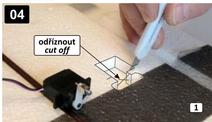
V křídle (1) upravte otvory pro serva křidélek. Prořízněte zářez pro patky. Adjust openings for aileron servos in the wing (1).
